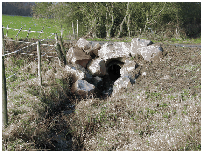
Mit Felsblöcken gesicherter Rohrauslauf des Dammbachs
