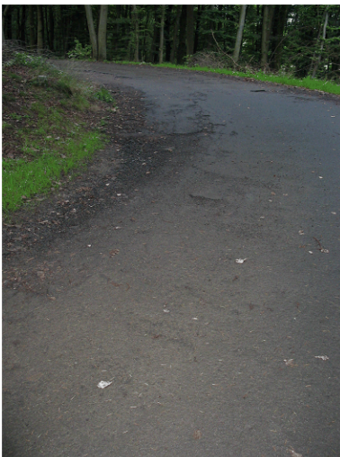
Abb. 2 – Aufweitung im Bereich der Innenkurve vorgesehen
